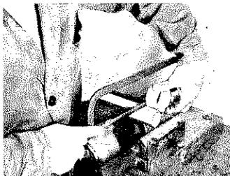
Schiebepprofile in gleichem Maße wie Schutzrohre kürzen.
